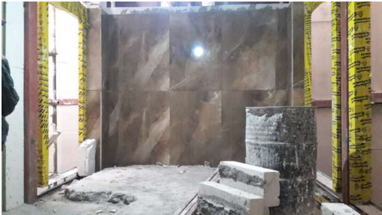
3- اجرای سنگ نمای پروژه
