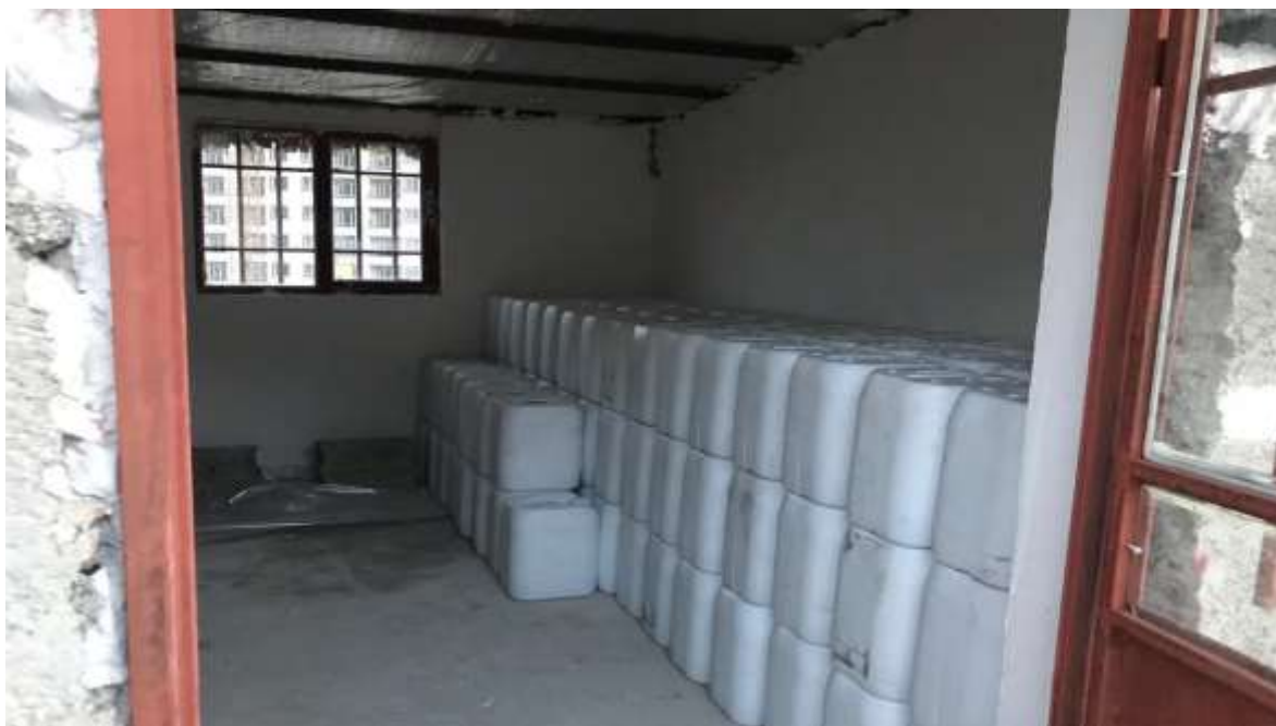
تجهیز کارگاه (ساخت انبار و اتاق کارگری)
